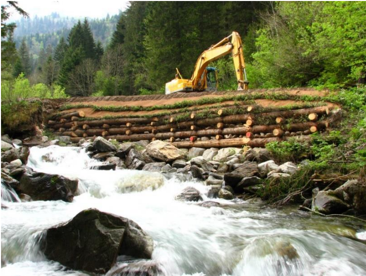
Figura 38: Esempio di intervento di ingegneria naturalistica, consolidamento di una sponda con struttura con tronchi (Fonte: creative commons, Anémophile licenza 4.0)
